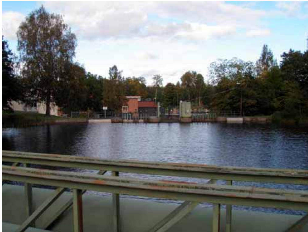
Figur 7. Dammvall vid utlopp till ursprunglig älvfåra. Foto: Olof Pettersson, mot ÖNÖ.
