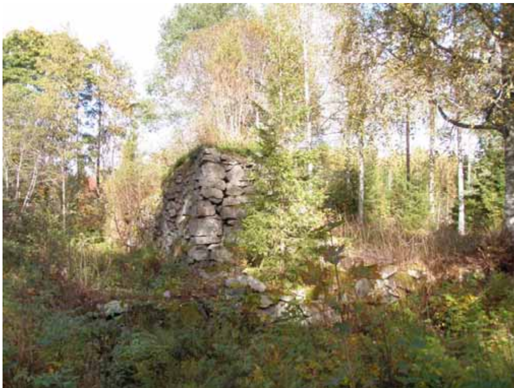
Figur 24. Ramp till kolhus. Foto: Olof Pettersson, mot NNV.
