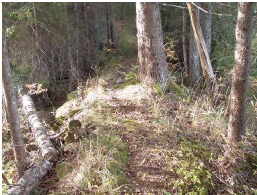
Figur 21. Den norra dammvallen, objekt 152-153. Foto: Åsa Westin, mot V.
